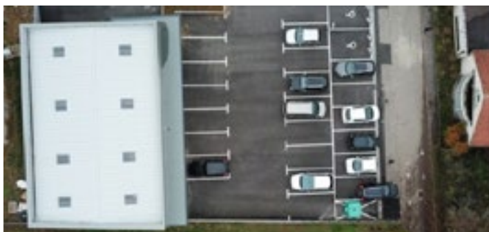
L'aménagement de la voirie (parking et rue de la Goulue) ainsi que la création du nouveau local technique sont les plus gros investissements réalisés ces 10 dernières années.
